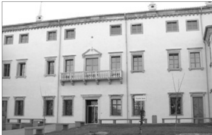
Pročelje obnovljene vile Vipolže
