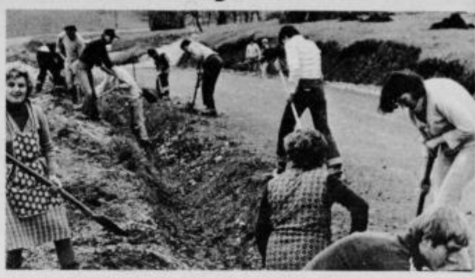
Ob asfaltu še urejanje bankin.
