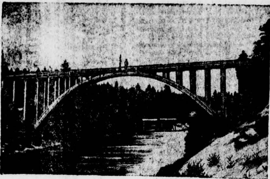
Die neue Traunfallbrücke, die die zwei Gemeinden Roitham und Tessenbrunn in Oberösterreich verbindet, hat eine Länge von 108 Metern, eine Breite von 7 Metern und erhebt sich in einer Höhe von 28 Metern über dem Wasserpiegel. Die Spannweite beträgt 71 Meter, sie ist die erste Brücke in Österreich, die nach dem System des Herrn Oberbau- rates Dr. Ing. Fritz Emersberger gebaut wurde.
