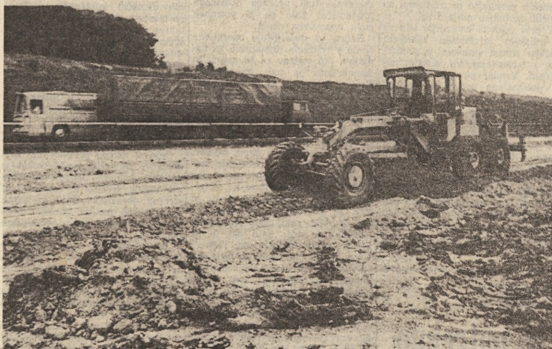
Buldozerji že rijejo po terenu, koder bo stekel drugi del avtomobilске ceste, ki bo povezovala Beograd z Nišem. Preko buldozerja vidimo tovornjak na prvi trasi iste ceste
