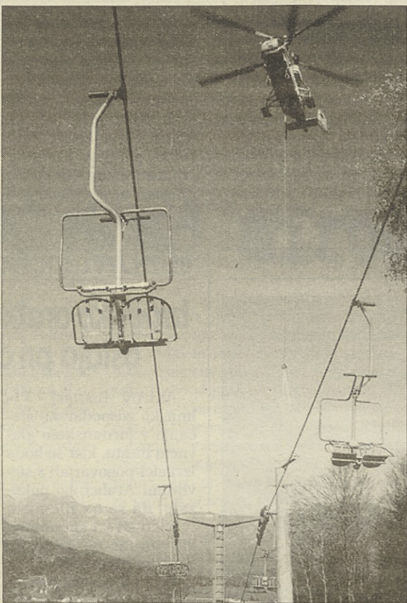
Gradnja štirisedežnice poteka brez zapletov (Foto: R. B.)
