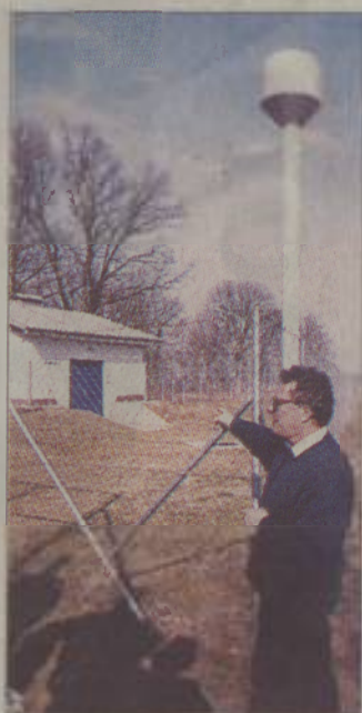
Vodovodni stolp, visok 38 m, drži 200 m 3 vode. Edini pri nas, na Madžarskem pa ni nobena redkost.
