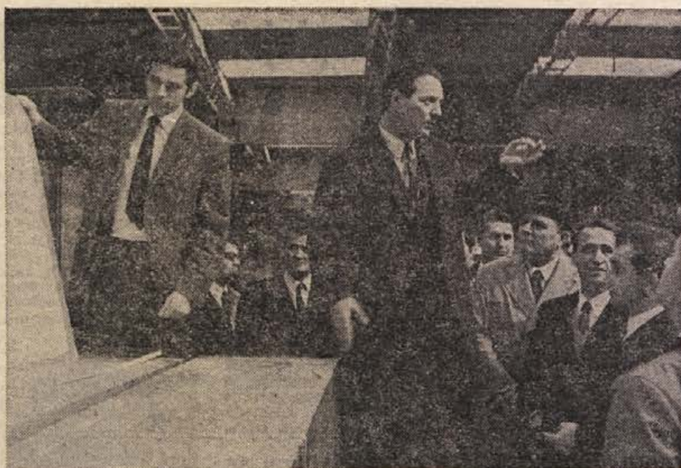
V ORJASKEM SKLADIŠČU LISCE: gostje so si za občinski praznik ogledali še graditev 10.000 površinskih metrov velikega skladišča, ki ga gradi novomeško podjetje Pionir. Krmeljska Metalna je vanj vgradila več sto ton konstrukcij. (Foto: M. L.)
