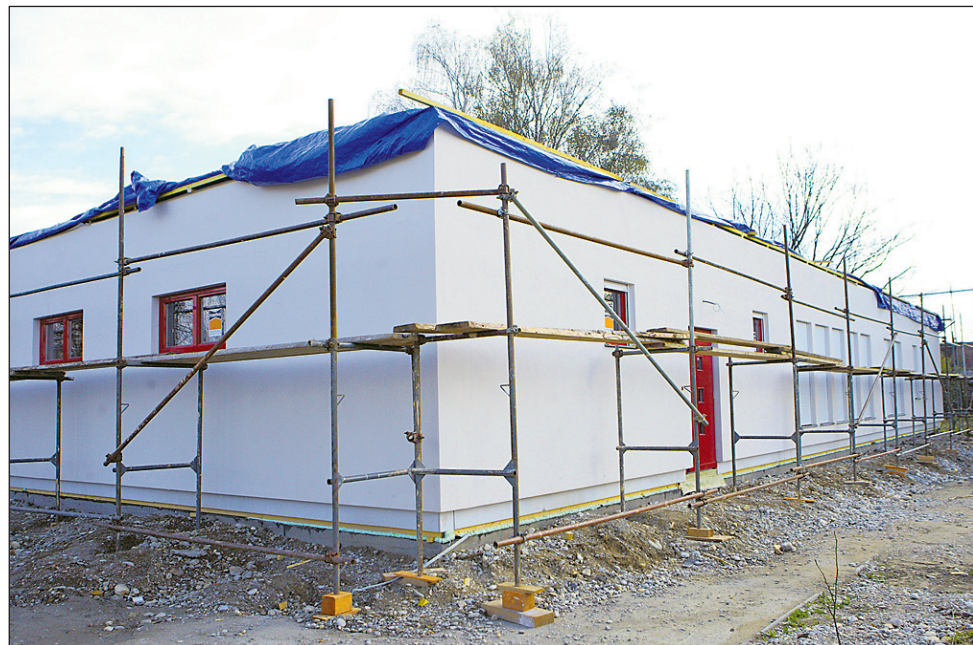
Novi vrtec Zvonček, ki ga MO Ptuj gradi na osnovi podeljene stavbne pravice, je že pod streho. Odprli ga bodo predvidoma januarja prihodnje leto.
