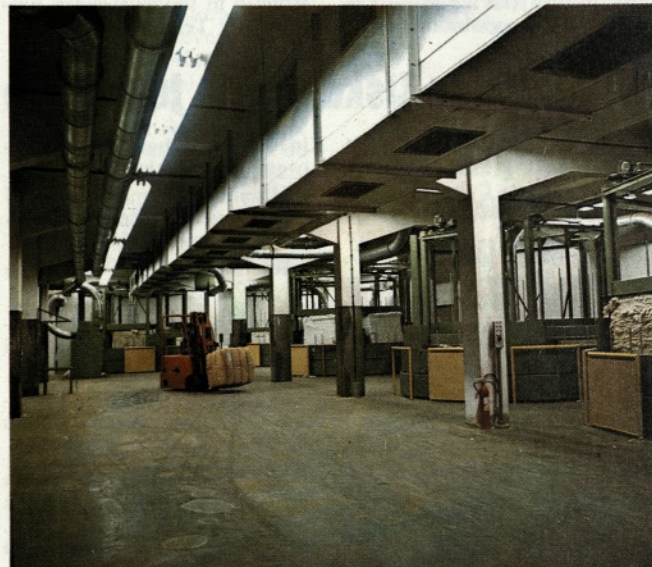
Čistilnica: pogled na karusel stroje (vrtiljake)
