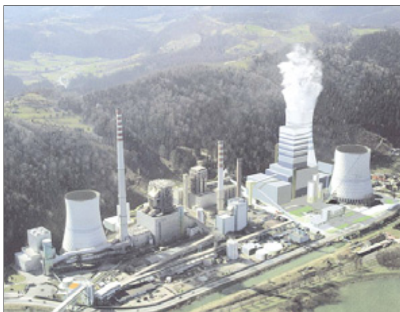
Izpusti v Termoelektrični centrali Šoštanj (TEŠ)
