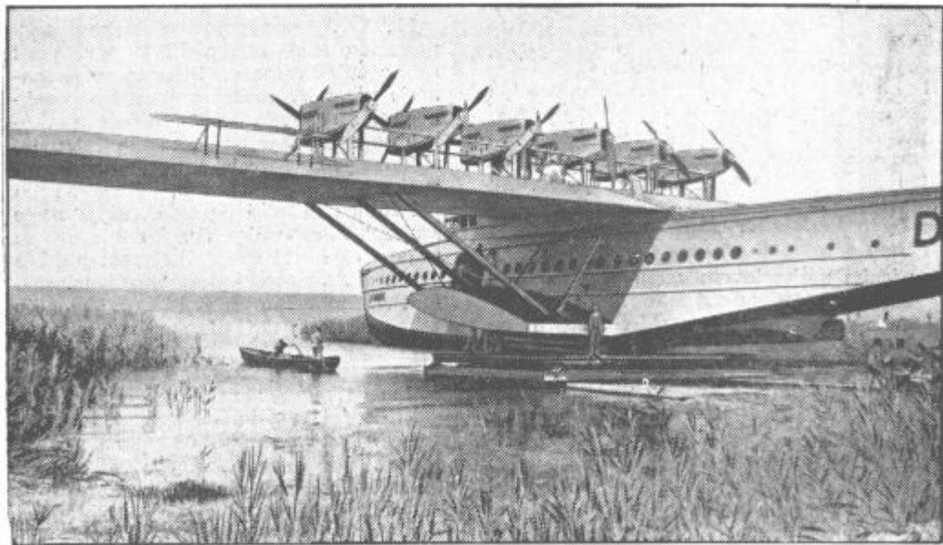
Preurejeno letalo »Do X« z 12 ameriškimi motorji po 600 ks na vodno hlajenje. Prej je bilo opremljeno z motorji na zračno hlajenje
