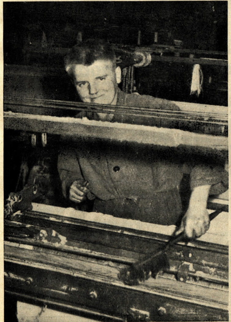
Čiščenje statev v tkalnici I
