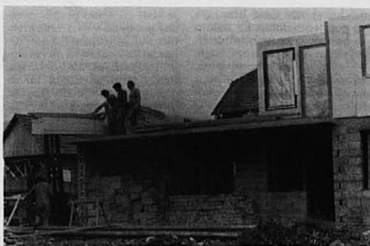
Montažna gradnja je hitra in zato cenejša.
