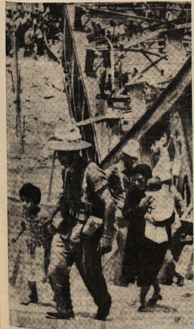
Porušeni most čez reko Jordan, po katerem je veliko število arabskih beguncev zapustilo svoje domove. Izraelske oblasti so sicer sedaj dovolile beguncem povratek na njih domove, toda postavljajo številne pogoje, tako da se mnogi ne morejo vrniti. Slika kaže žene s otrokoma, ki se je vrnila po mostu na zasedeno ozemlje
