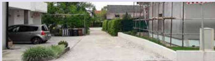
Asfaltiranje in urejanje odvajanja meteorne vode na 40 m odseku Japljeve ulice
