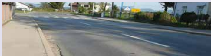
Na Grobeljski cesti bo od gasilskega doma do križišča z Detelovo ulico v celoti zamenjan spodnji in zgornji ustroj ceste, izvedena rekonstrukcija pločnika in ureditev odvodnjavanja
