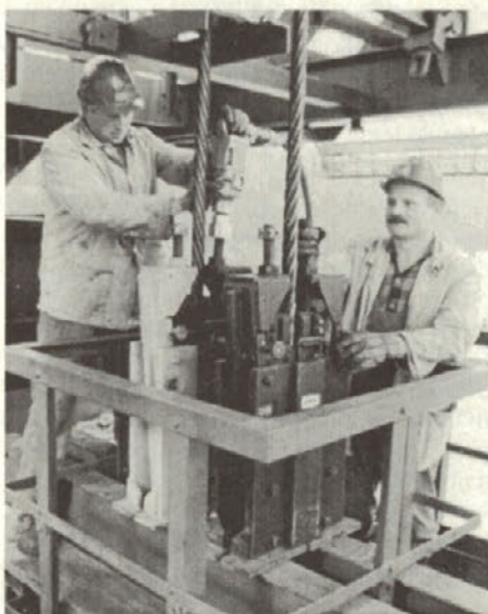
Vpetje novozgrajenih izvoznih vrvi Ø41 v stoječe vrve prižeme na izvoznem stroju GHH - s strojem dela Aleksander Berložnik, vijake kontrolira poslovodja Franc Videmšek (foto I. P.)
