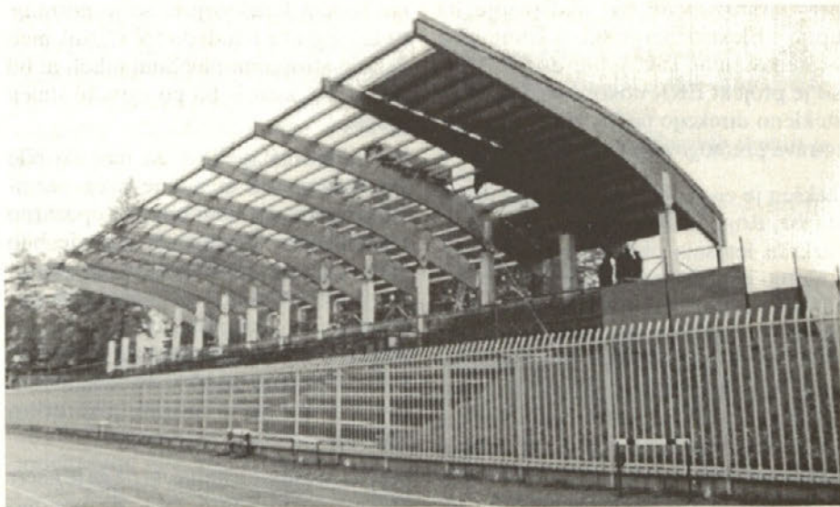
Pogled na gradnjo tribun sredi maja (foto I.P.)
