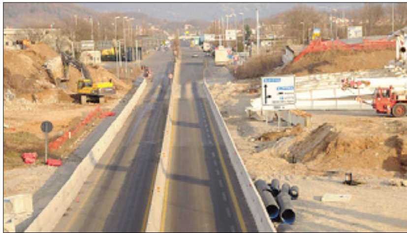
Nad hitro cesto nadvoza ni več
