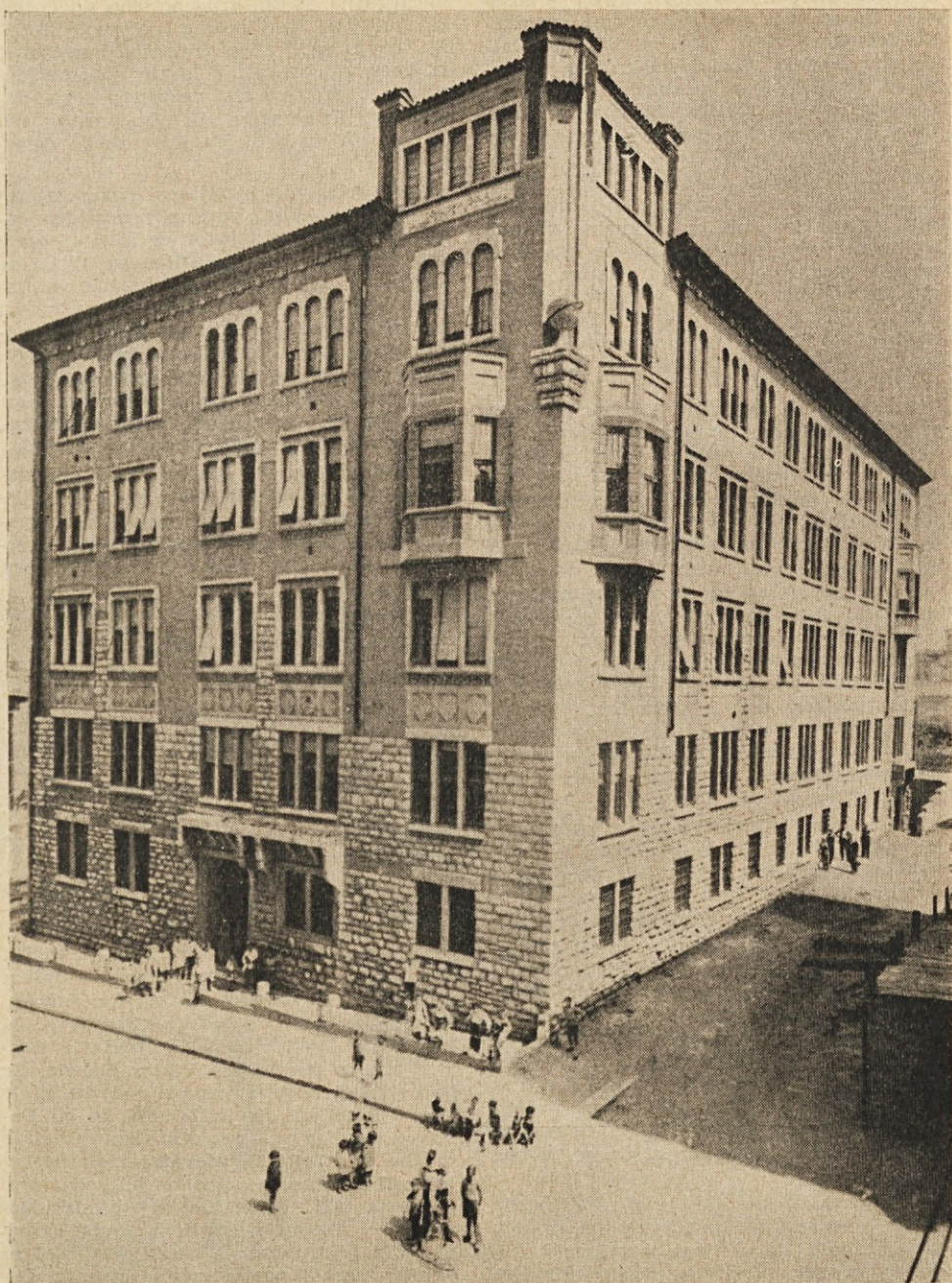
Stavba šole pri Sv. Jakobu v Trstu do bombardiranja l. 1943
