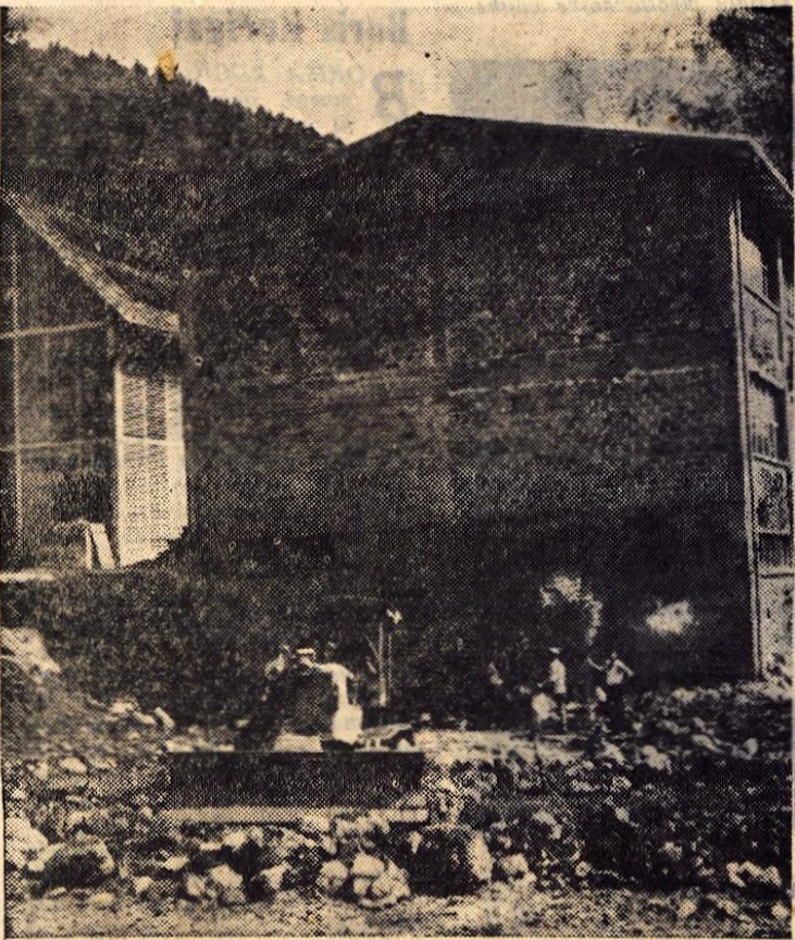
Rekonstrukcija tovarne lepene Tržič — zemeljska dela za gradnjo novega obrata
