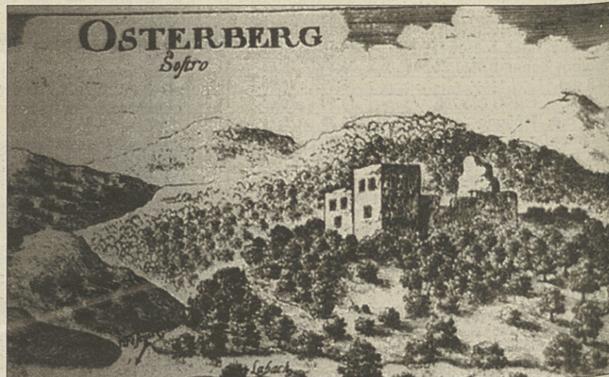
Grajske razvaline danes (na zgornji sliki) in v Valvasorjevi dobi (Foto: Ivan Jakic)
