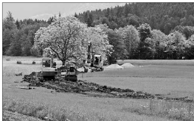
Izkopavanje tlačnega kanala se približuje čistilni napravi v Gornjem Gradu.
