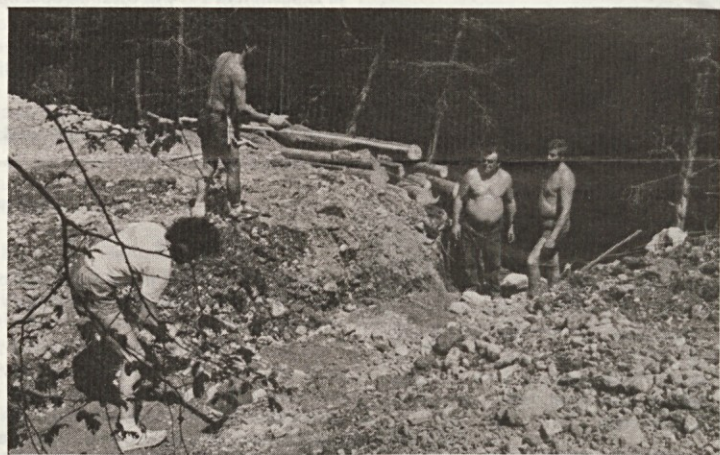
Začetek zemeljskih del na MHE Bača - Podbrdo (Foto: V. Jantol)
