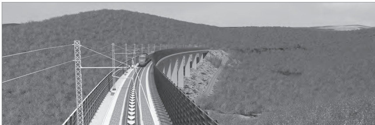
Slika 8: Viadukt Vinjan – dokončen pogled na drugi tir
