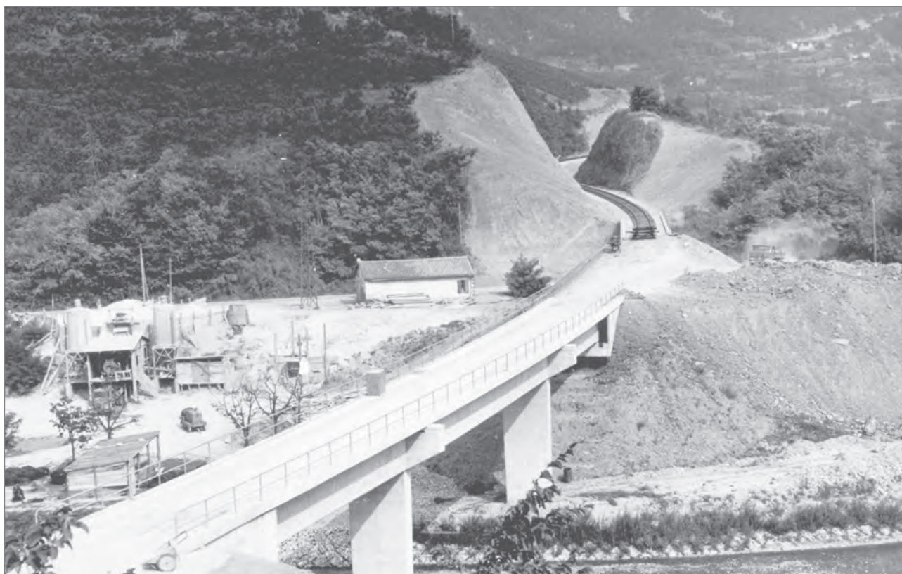
Slika 4: Gradnja premostitvenih objektov preko ceste za Kubed in reko Rižano; v ozadju pogled na plazišče Loka pred izgradnjo umetnega predora.
