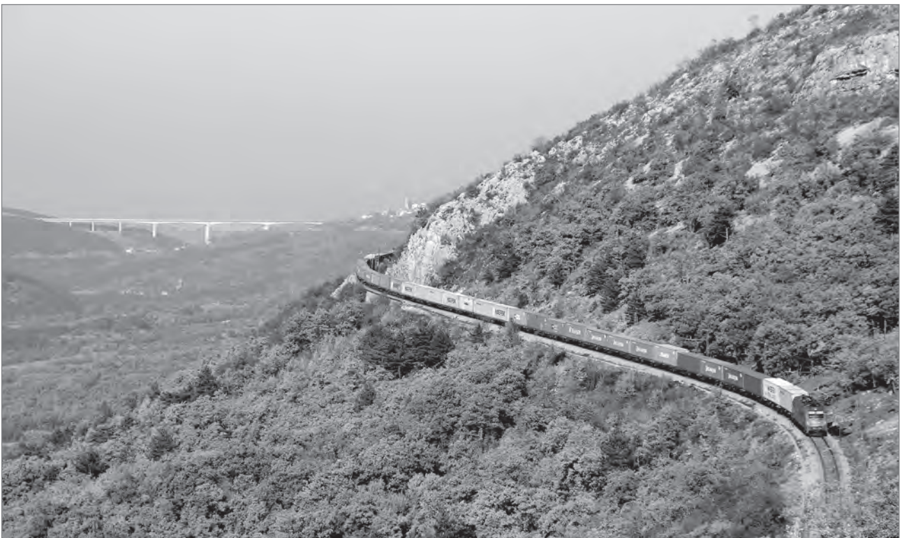
Slika 6: Zanimgrad, Črni Kal – kontejnerski vlak proti Kopru
