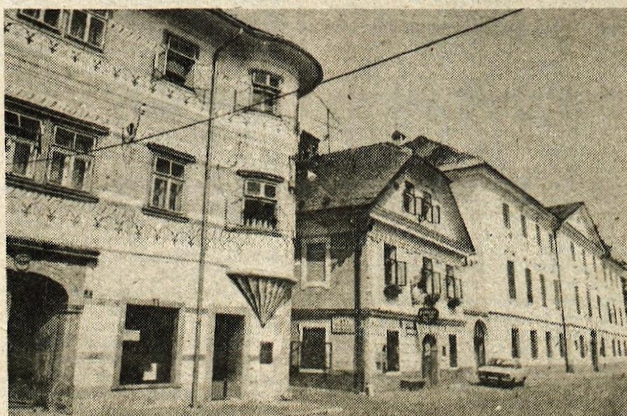
V zadnjih dveh letih so veliko pozornosti posvetili prenovi starega radovljiškega mesta. Fasade so prepletkane, nekatere hiše so tudi znotraj prenovljene. Ni pa jim še uspelo zapreti Linhartovega trga za promet, čeprav bi avtomobile lahko preusmerili na novo obvoznico za Kropo. Foto: F. Perdan
