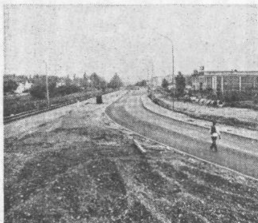
Med graditvijo II. faze Celovške ceste bo speljan promet za gorenjsko smer po Servisni cesti. Servisna cesta je dolga 2400 metrov in se od Celovške ceste odcepi pri gostilni Žibert, pelje do železniške proge in ob njej do Djakovičeve ulice. (Foto: Janez Šušter)
