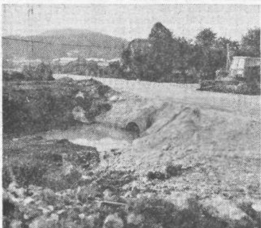
Dela na Vodnikovi cesti, po kateri bo speljan promet med graditvijo II. faze Celovške ceste, potekajo malo počasneje, kot so jih načrtovali. Delni vzrok je težak teren in voda, nenazadnje pa tudi nekaj nerešenih zemljiških vprašanj. (Foto: Janez Šušter)
