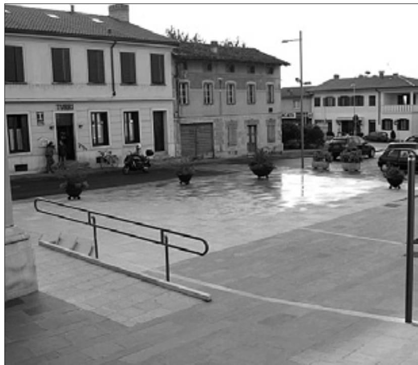
Obnovljeni štandreški trg
