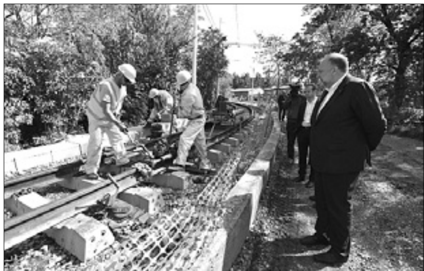
Župan opazuje delavce pred športnim središčem na Kolonji
