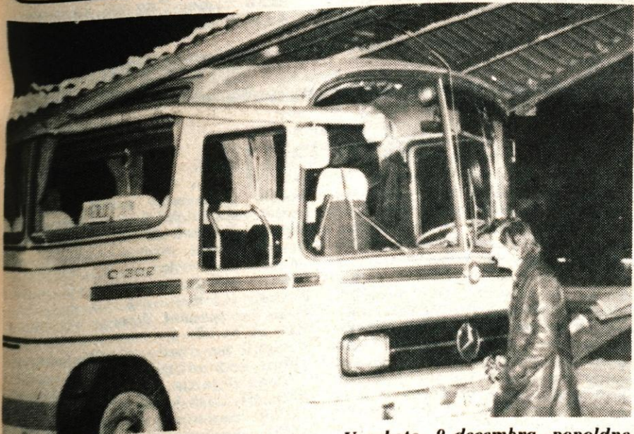
STREHA PADLA NA AVTOBUS — V soboto, 9. decembra, popoldne se je na jeseniški avtobusni postaji pripetila nenavadna nesreča. Avtobus tržiške BPT je na poledenelem vozišču zaneslo za pločnik avtobusne postaje, kjer je trčil in nosilni steber strehe. Zato je strešna konstrukcija padla na avtobus, na katerem je na srečo nastala le manjša materialna škoda, prav tako pa tudi ni bilo ranjenih. — B. B.
