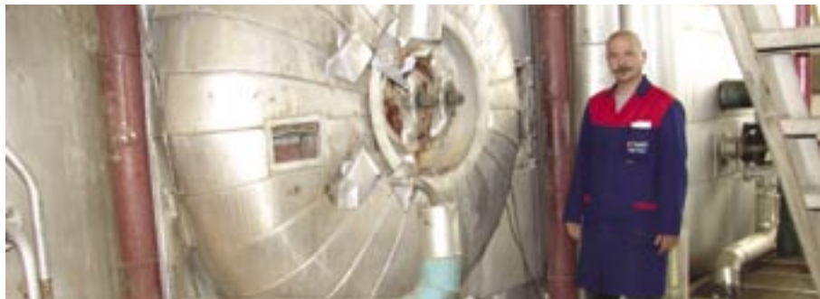
Vodja remonta ob kotlu
