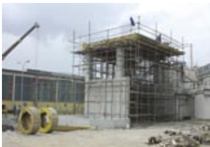
Slika 3: Betonski del objekta, v katerem bosta nameščeni centrifugi
