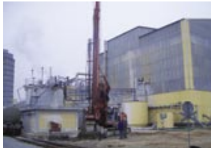
Slika 2: Prvi pilotni temelj proizvodnje CEGIPSA
