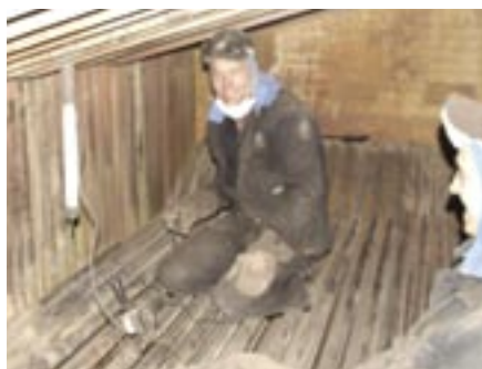
Delavec Dimnikarstva čisti notranjost parnega kotla
