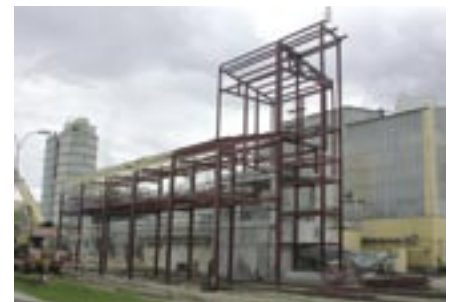
Slika 5: Končna oblika konstrukcije proizvodnje CEGIPSA
