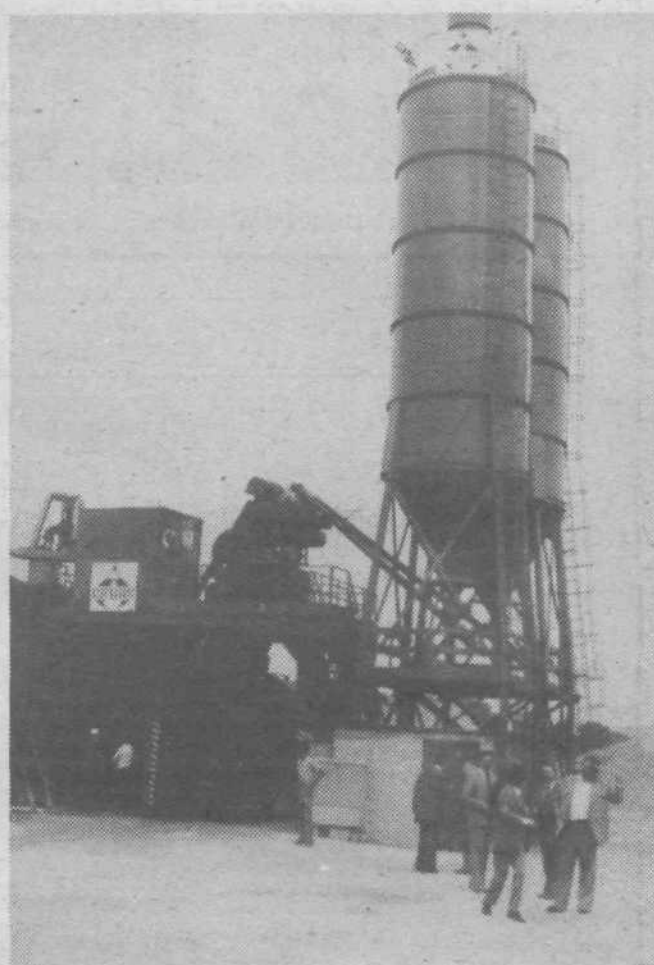
Prva domača z računalnikom krmiljena betonarna stoji v Novih Jaršah v Ljubljani
