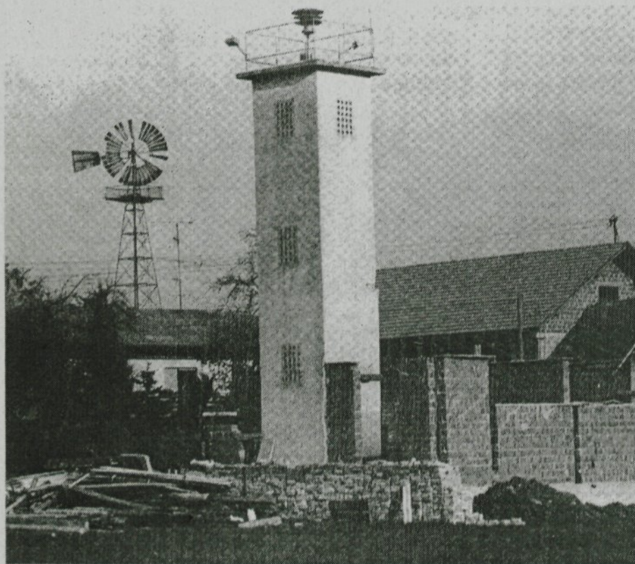
Udamov vodnjak z vetrnico za pogon črpalke, sušilni stolp in gradnja gasilskega doma v Topolah v letu 1990.
