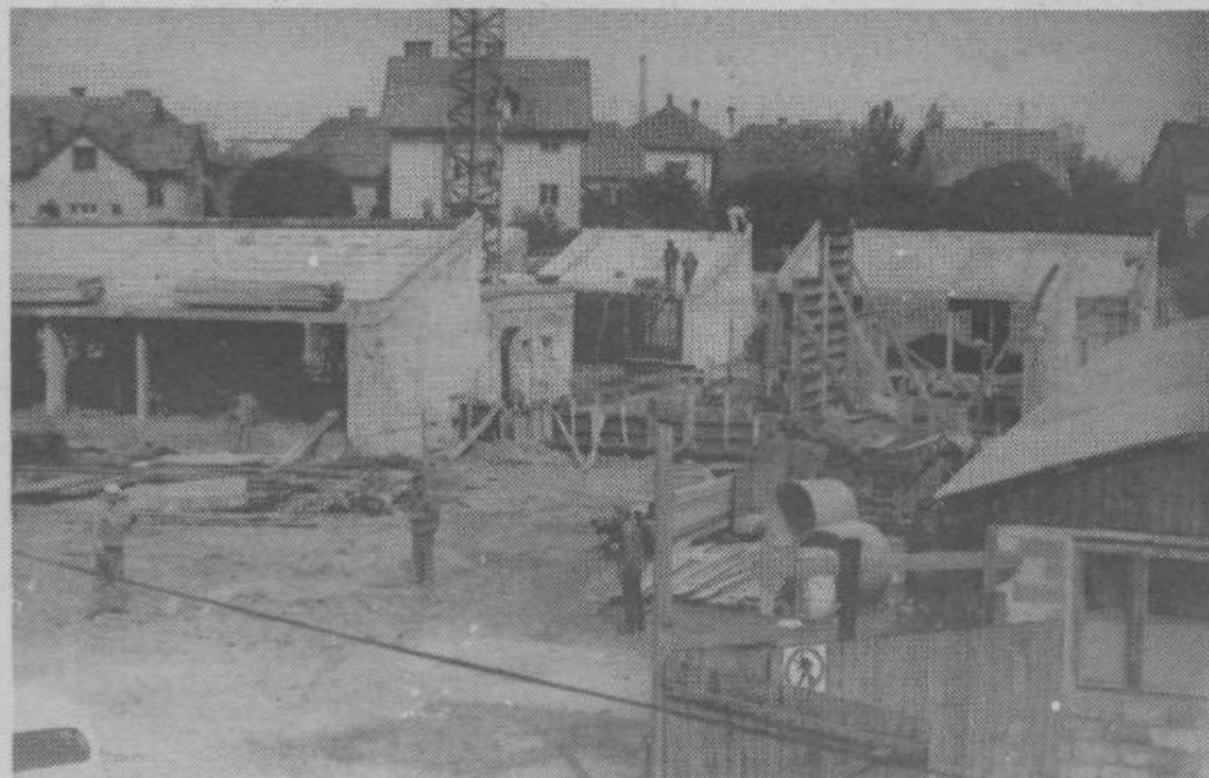
VYZ SELO V IZGRADNJI — gradbena dela so v teku
