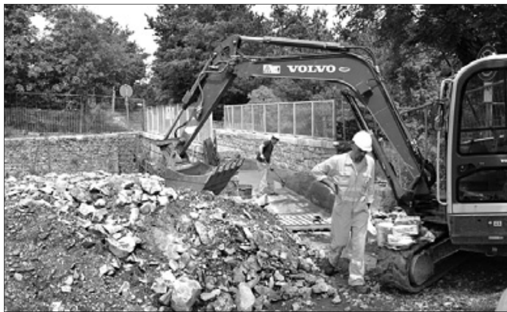
Dela na mostu čez železniško progo Trst-Opčine
