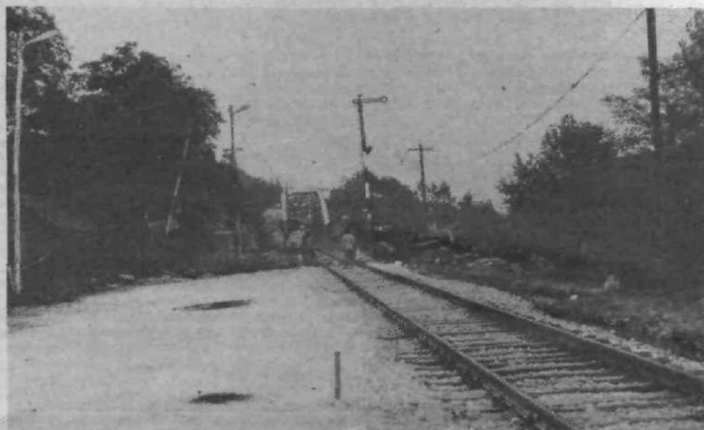
Čez dan ali dva bodo začeli z obnovo še precej dotrajanega črnuškega mostu čez Savo. Tovarnjaki bodo do konca oktobra, ko bo obnova predvidoma končana, vozili skozi Tacev ali Šentjakob, osebni avtomobili pa bodo v eni smeri vozili preko starega črnuškega mostu, v drugi smeri pa si bodo delili »življenjski prostor« s »Kamničanom«, saj bo promet spajen preko železniškega mostu (na sliki). Za začetek del je že vse nared, gneča na cesti pa bo zdaj prav gotovo še hujša, kot smo je vajeni ob prometnih konicah, zato se najbrž tudi voznikom osebnih avtomobilov spleta zapeljati do Šentjakoba ali Tacev.
