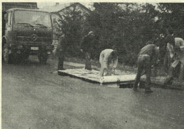
Slika 3. Polaganje polipropilenske tkanine na probnem polju 1
