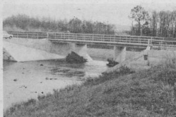
Z regulacijo so bili zgrajeni tudi novi prometni objekti
