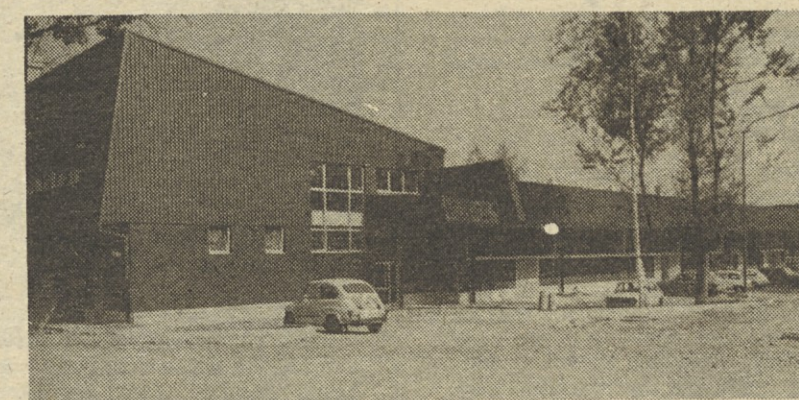
Gradbena dela so končana, stavba se lepo vključuje v okolje. Delavci urejajo okolico; ko to pišemo pripravljajo vse potrebno za asfaltiranje okolice in parkirišč. Pri tem imajo velik delež mladinci TOZD Elektroliti, ki so pomagali z udarniškim delom. Asfaltirali bodo zadnje dni pred otvoritvijo.
