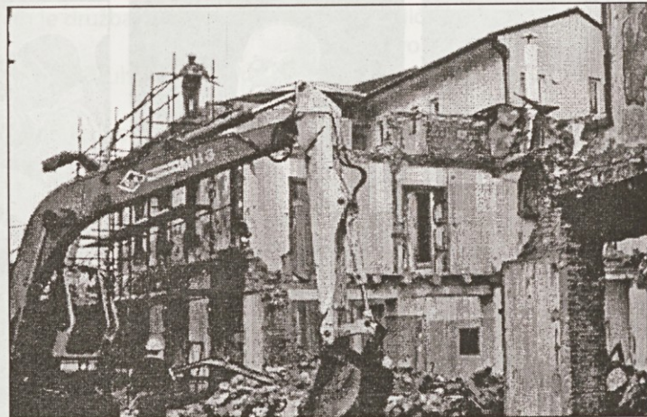
Stavba knjižnice med rušenjem...
