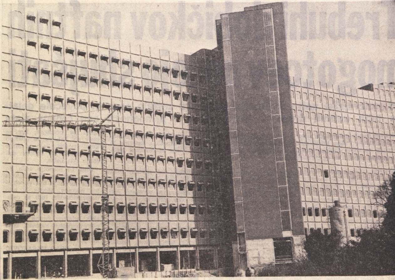
NOVA GORIŠKA BOLNIŠNICA — Osem nadstropij s teraso, dolga 100 m, visoka pa 45 m. Prvi bolniki se bodo vselili septembra 1975. Navpični elementi (na sliki nekoliko temnejši) so živo rdeče barve, medtem ko je fasada sicer modre barve.
