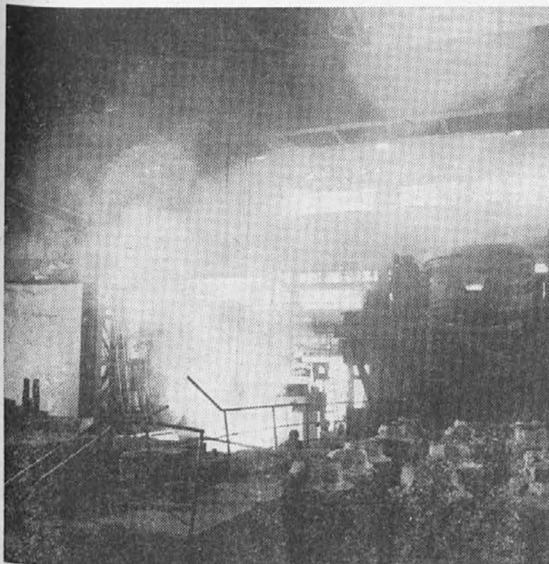
Novo ob starem: Na desni kad in ogrodje stare 5-tonske elektro obločne peči, na levi izpus taline iz nove peči
