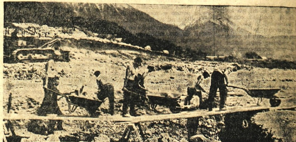
Delavci Gradbenega podjetja »Bled« so začeli pred dnevi z zemljskimi deli za novo šolo v Gorjah. Torej kaže, da bo naposled rešen dolgoletni šolski problem v Gorjah. Foto: F. Perčič
