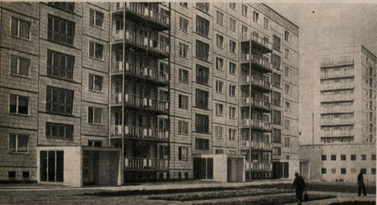
Primer stanovanjskega bloka z montažnimi »prislonejimi« balkoni. Fasada je obložena s keramičnimi ploščami, ki so položene že v kalup pred betoniranjem.
