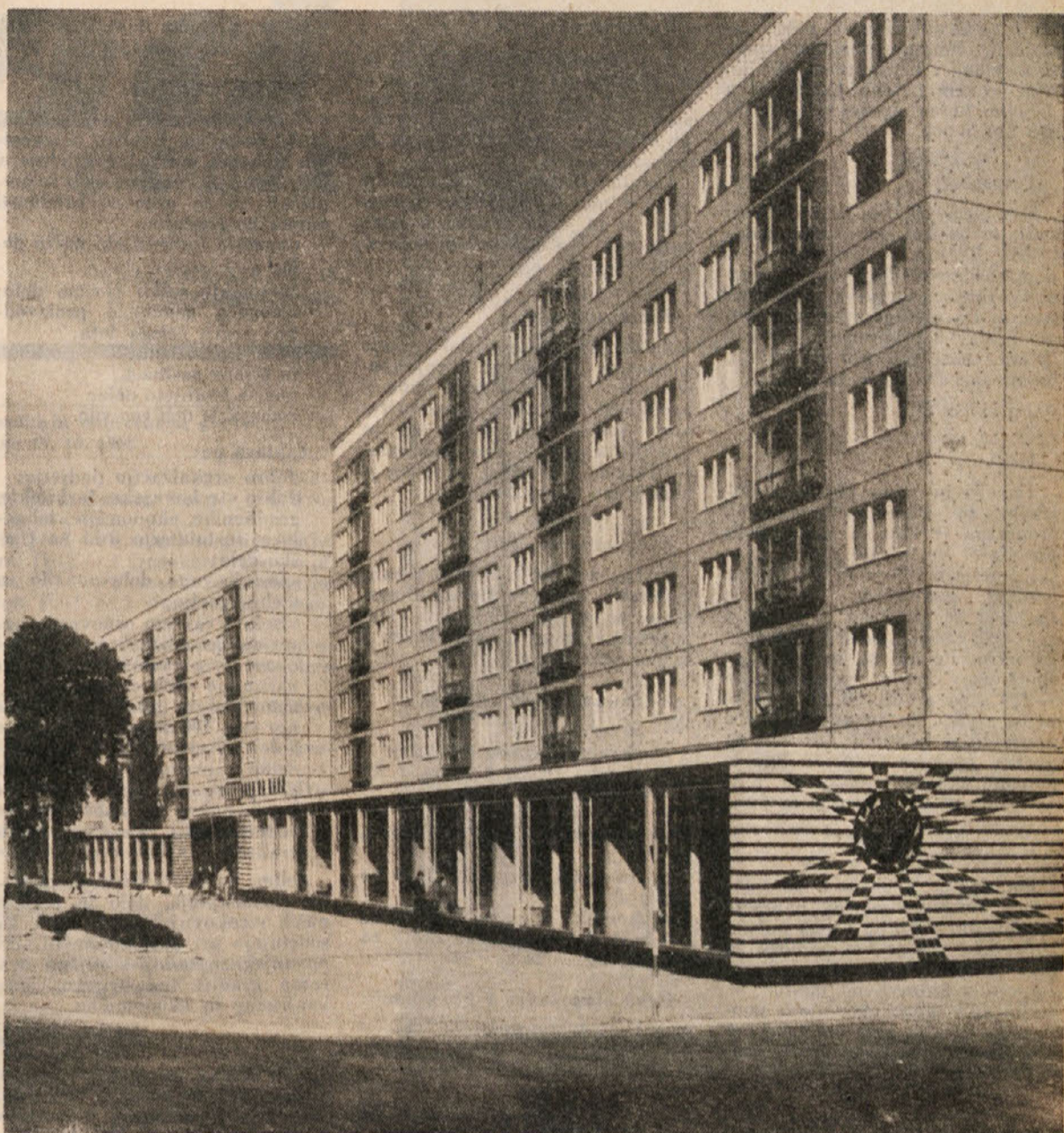
Slika predstavlja montažna stanovanjska bloka višine P + 6 etaž s pritličnimi prostori namenjenimi raznim gospodarskim uslugam. Tudi pritlični objekt je montažen. Fasada je arhitektonsko dovolj plastična in funkcionalna.
