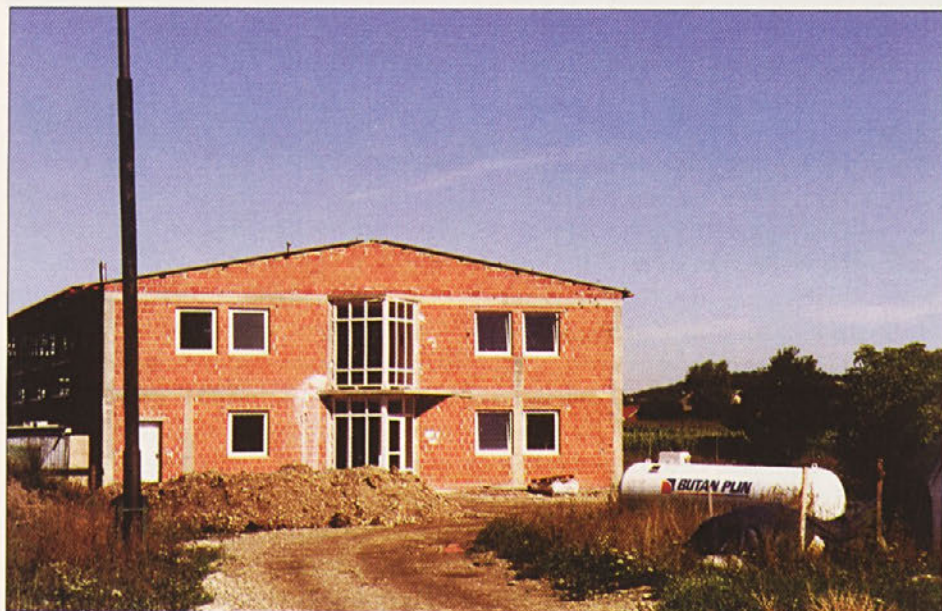
Industrijska cona v Forminu že dobiva podobo, saj je prvi od treh načrtovanih objektov že pod streho
