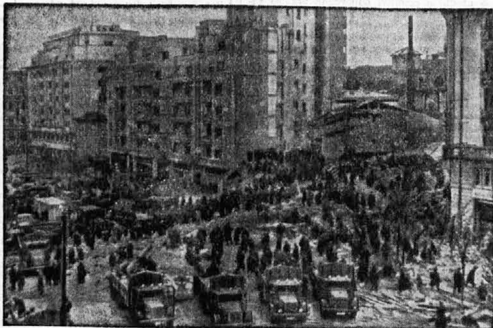
Sledovi, ki jih je v romunski prestolnici in skoraj po vsej Romuniji zapustil zadnji siloviti potres, še dolgo ne bodo zabrisani. V Bukarešti imajo še zdaj dela z odstranjevanjem razvalin. Slika kaže prizor izpred bloka »Carlton«, odkoder s tovornimi avtomobili odvažajo podrti zidovi.
