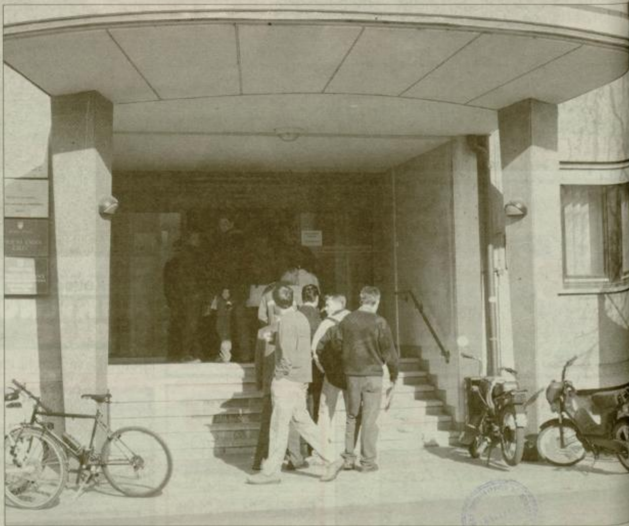
Gneča sega celo pred vhod upravne stavbe v Žalcu.
