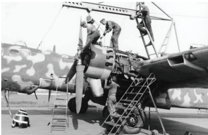
Menjava motorja. Tu se vidijo izpušne cevi brez skrivalcev plamena.
