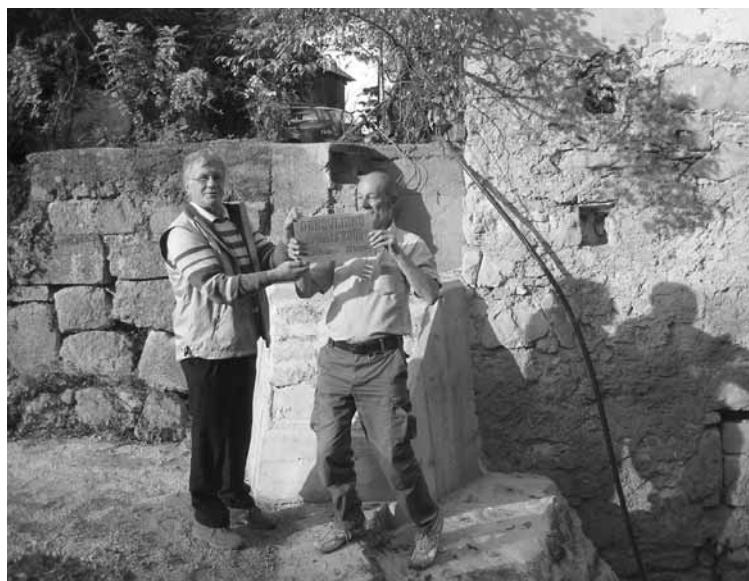
Pritrditev spominske plošče na obnovljen jez
