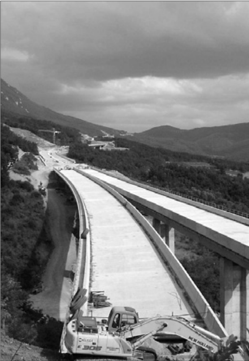
Gradnja odseka čez Rebernice
