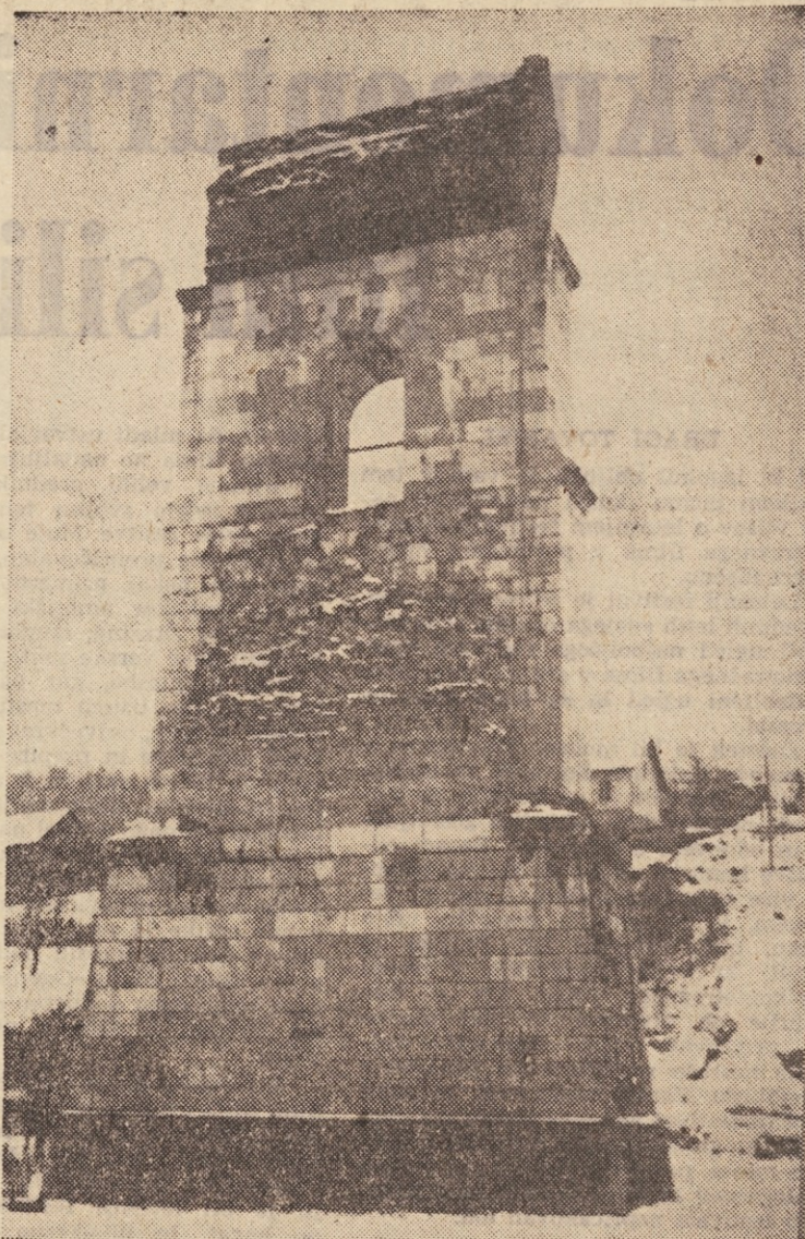
Med 26. nosilci nekdanjega 50 metrov dolgega železniškega vialukta v Borovnici, je ostal le še 48 metrov visok steber kot spomin na vojni vihr. Med vojno šestokrat porušen vialukt smo po vojni zamenjali z novo železniško traso, most pa dokončno porušili. Ostal je eden izmed steberov, ki ga je vzel v zaščito zavod za spomeniško varstvo LRS. Pred nedavnim so steber restavrirali, ter ga zaščitili pred propadanjem.
