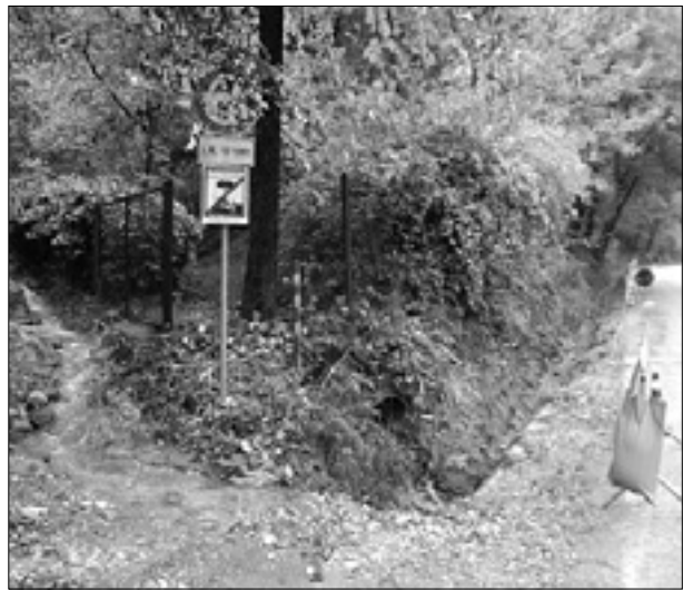
Voda dere s pobočja na cesto v Grojni
